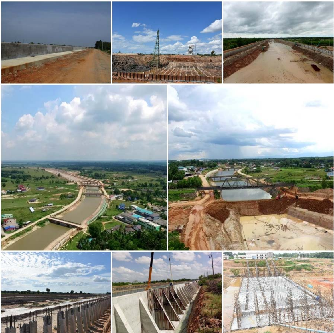
รูปที่ 10 ความคืบหน้าการก่อสร้างโครงการบรรเทาอุทกภัย อ.หาดใหญ่ (ระยะที่ 2) จังหวัดสงขลา กรมชลประทาน
